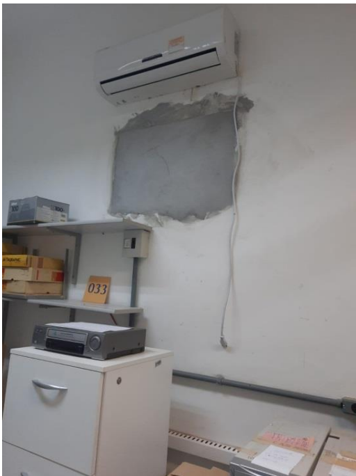
Figura 35 – foi solicitada a abertura de uma janela na sala
