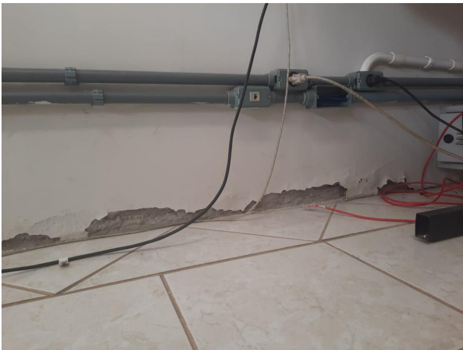
Figura 25 – parede com reboco aparente
