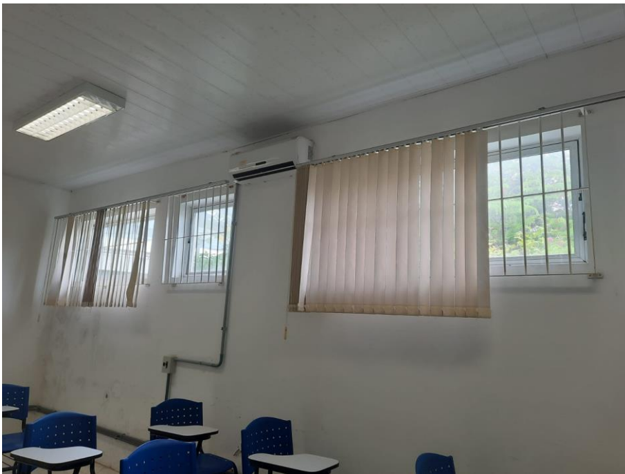
Figura 45 – Janelas sem partes da persiana
