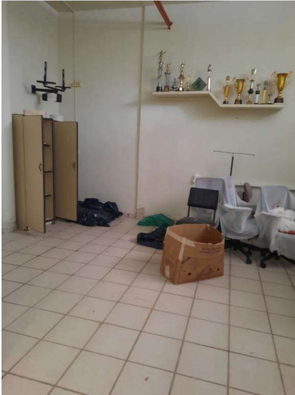
Figura 54 - sala precisa de manutenção
