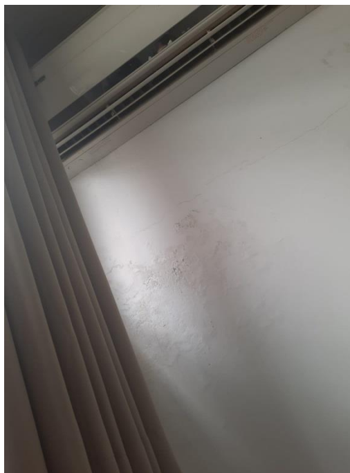
Figura 20 – infiltração sala 31
