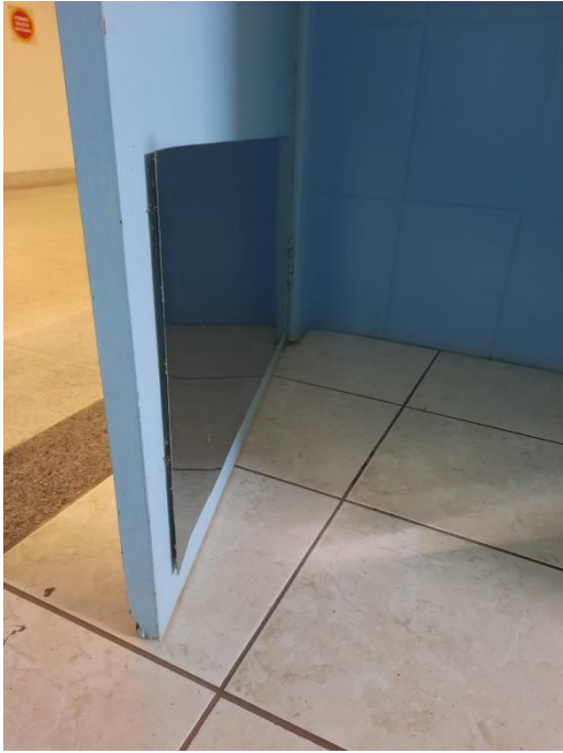
Figura 8 – espelho da porta está soltando
