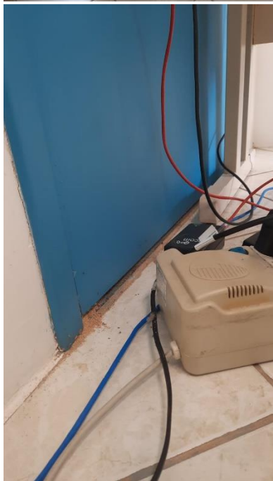
Figura 55 – porta inutilizada com cupim
