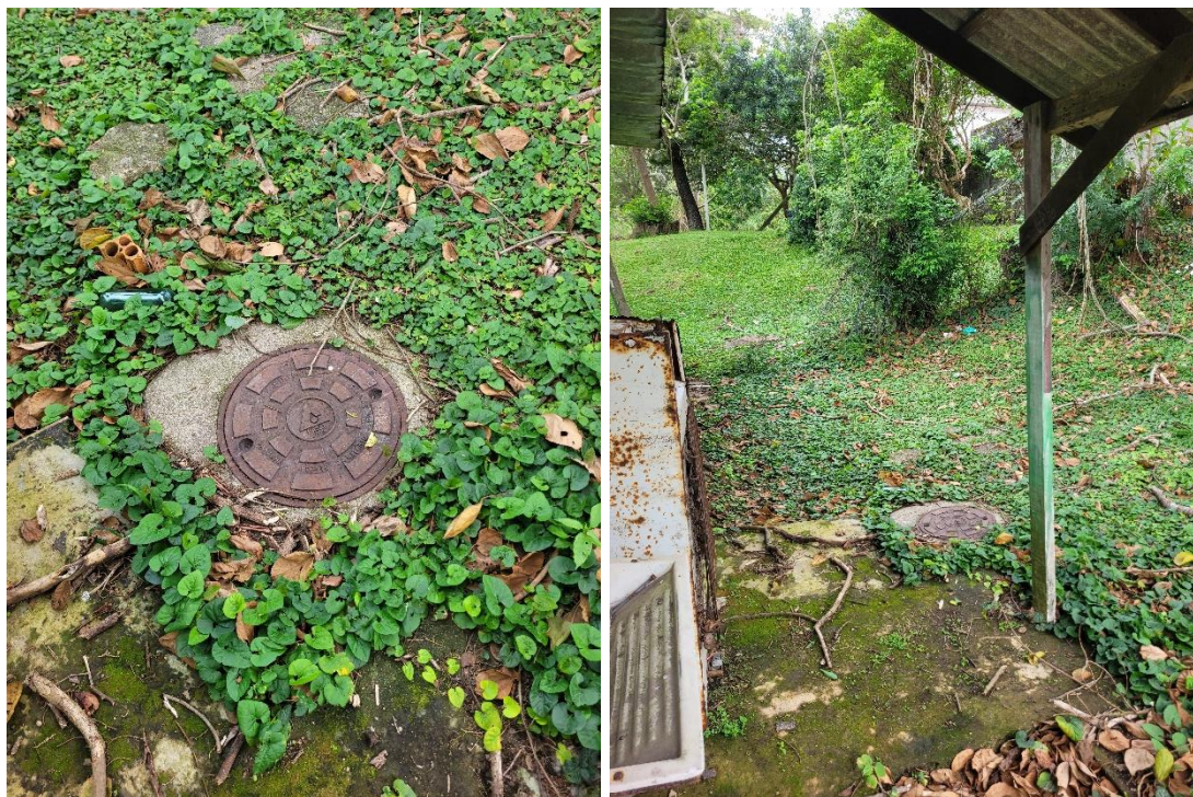
Figura 2 - Poços de Visita da rede de esgoto da CASAN. Fonte: elaborado pelos autores.
